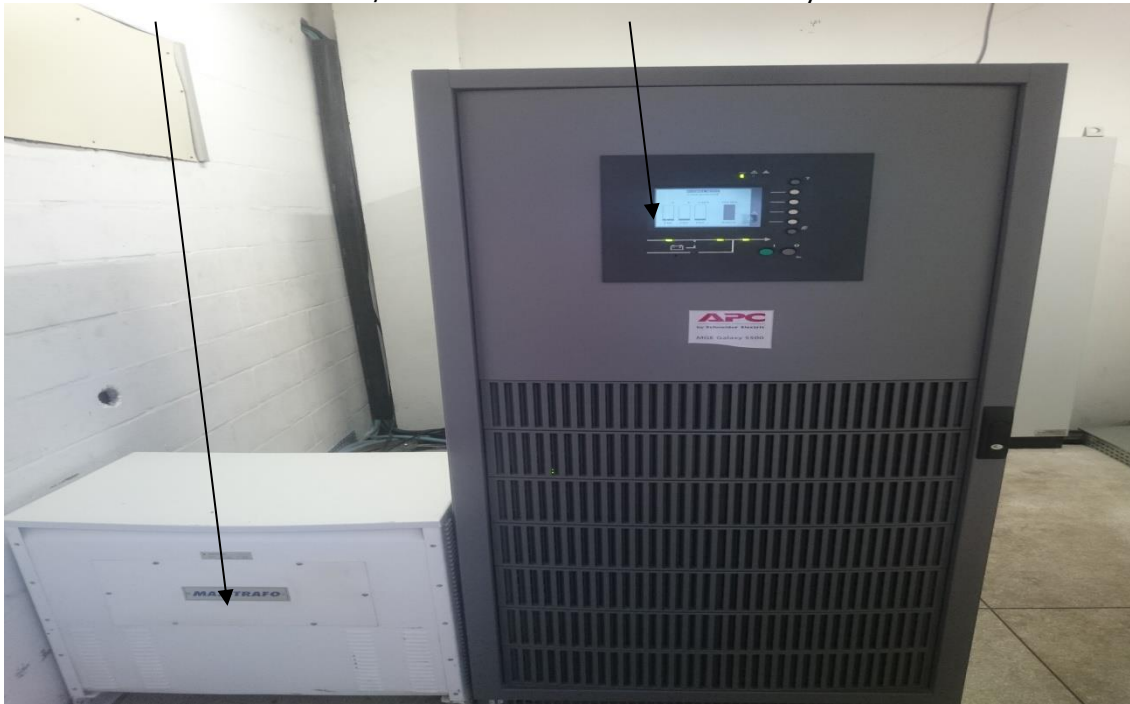
Sala de Infraestrutura Física de TI da SEFAZ/ES - (SALA 2).
