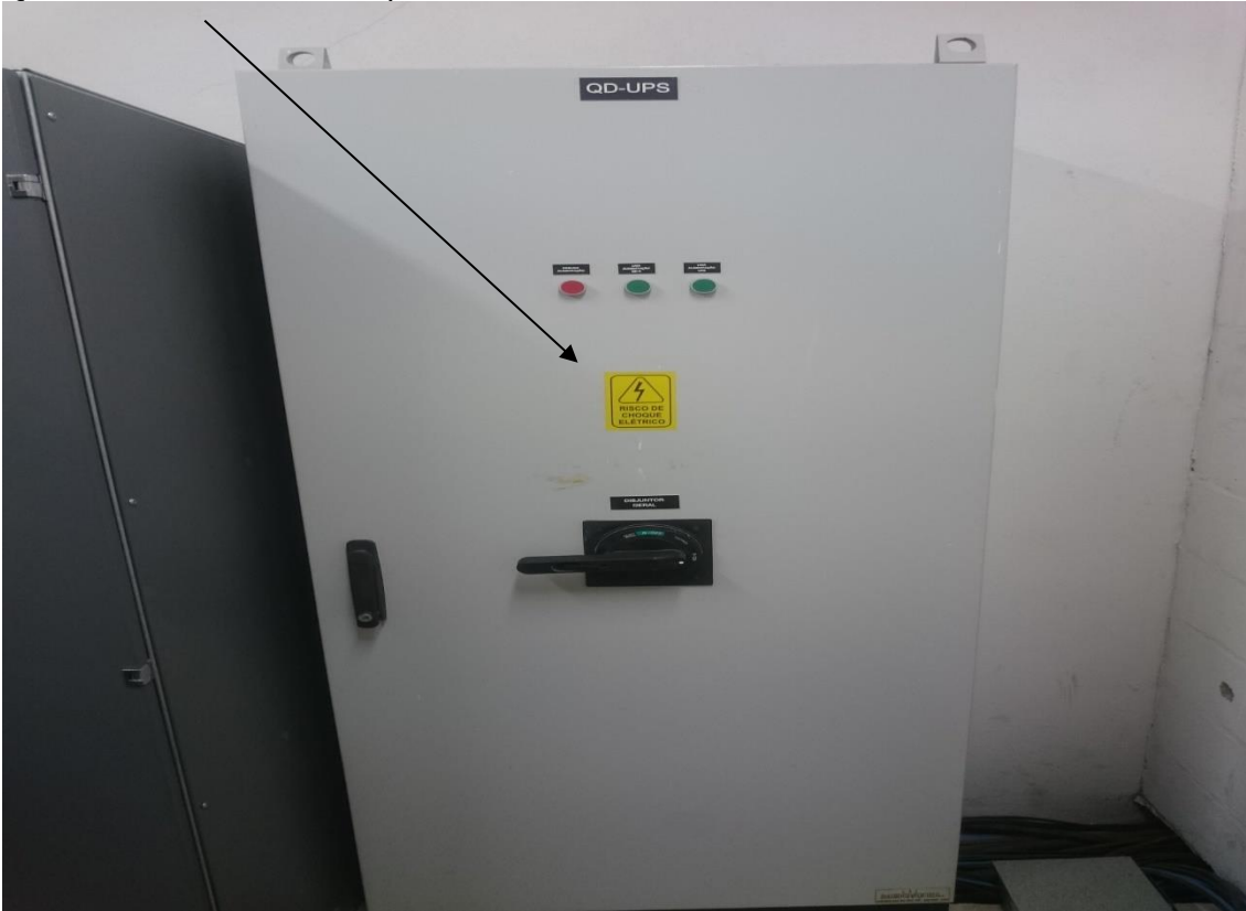
Sala de Infraestrutura Física de TI da SEFAZ/ES - (SALA 2).
