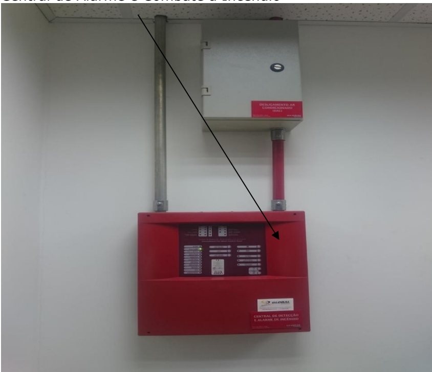
Sala de Infraestrutura Física de TI da SEFAZ/ES - (SALA 1).
