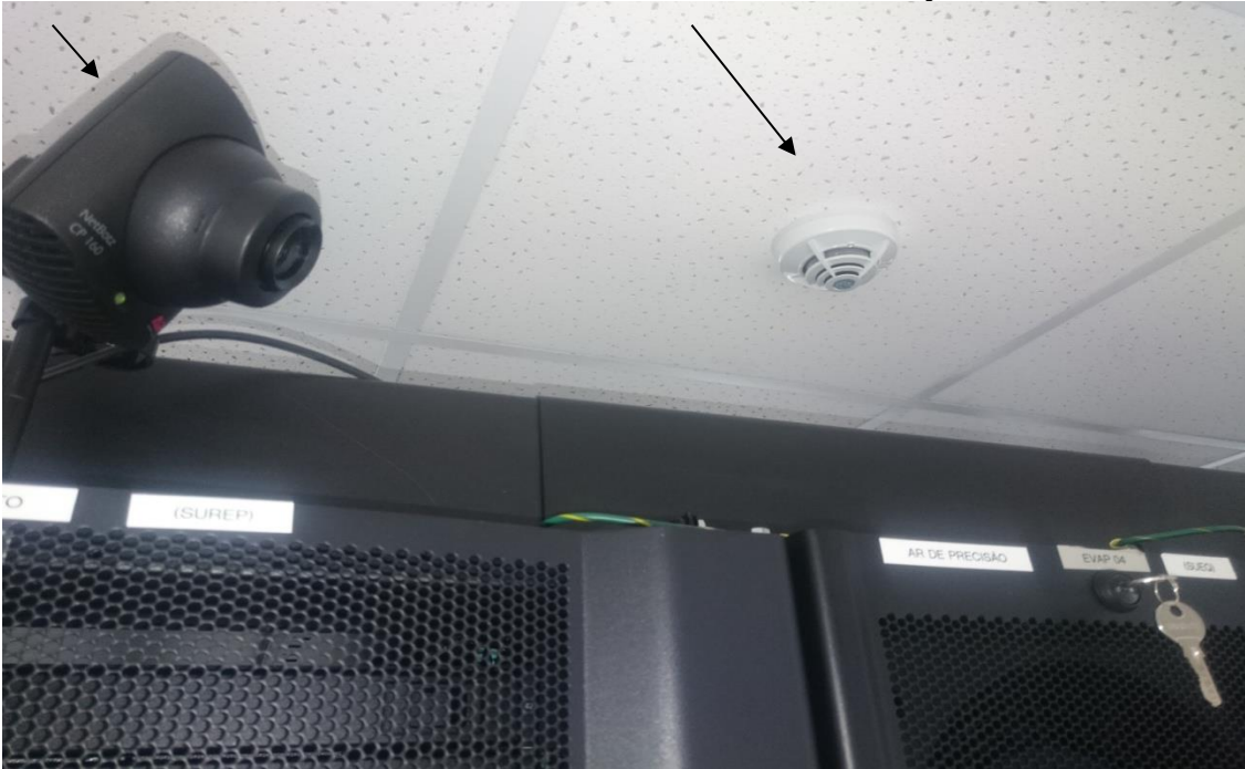
Sala de Infraestrutura Física de TI da SEFAZ/ES - (SALA 1).
